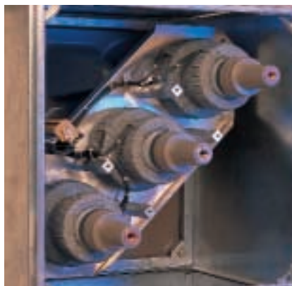
Тороидальные трансформаторы тока
