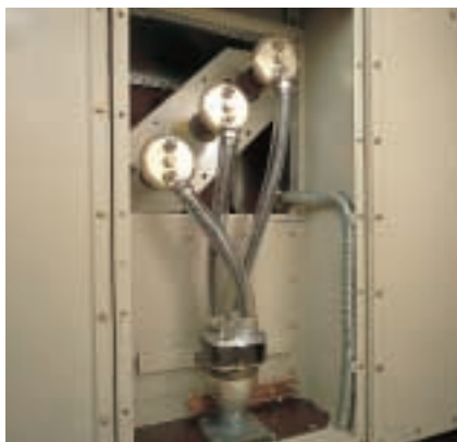
Подключение кабелей с помощью монтажных лепестков (вплоть до 17,5 кВ)
