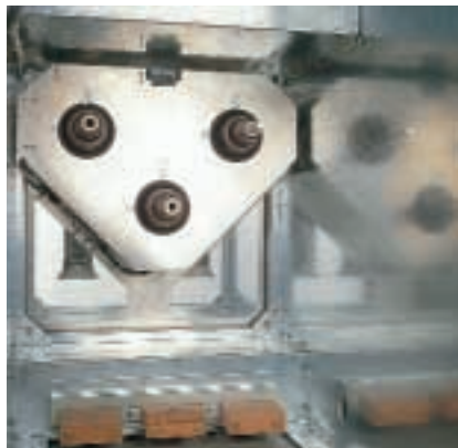
Подключение кабелей с передней стороны возможно при токах, не превышающих 1 250 А
