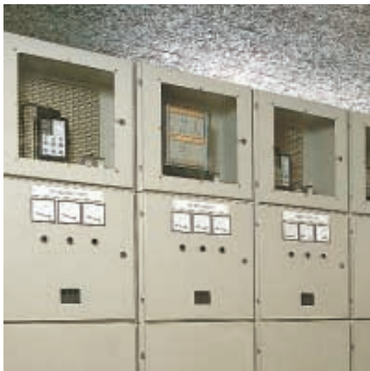
Установка Innovac MMS с традиционным вспомогательным оборудованием
