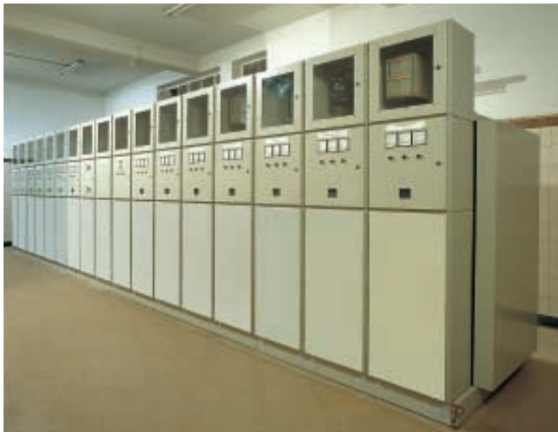
Установка Innovac MMS со двоянной сборной шиной
