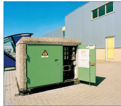
Magnefix на малогабаритных трансформаторных подстанциях и подстанциях компактных типов.
